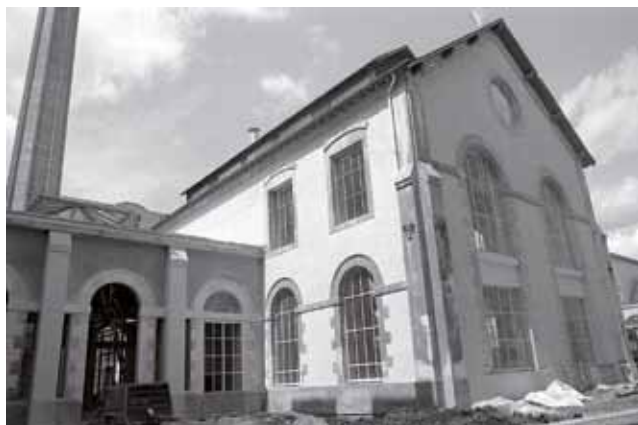
La Manu pendant la réhabilitation, la future bibliothèque en chantier - 1982 © BATI/Ville de Nantes
