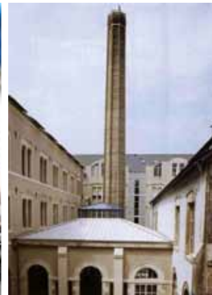
La Manu après réhabilitation vue de la bibliothèque et de la cheminée © BATI/Ville de Nantes (extrait de la revue Monuments Historiques 1983)
