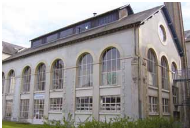
La Manu après réhabilitation - vue de la bibliothèque et de la cheminée © BATI/Ville de Nantes (extrait de la revue Monuments Historiques 1983)
